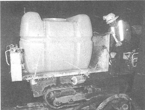
写真－２ キャリアダンプ＋タンク
