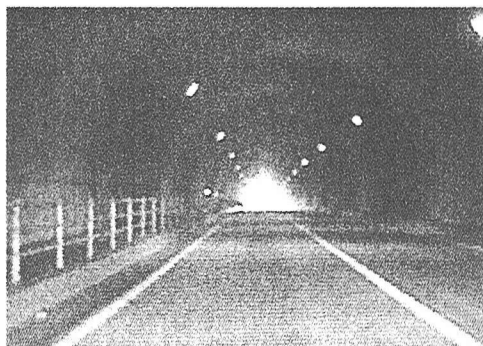
(a) ビデオー13 蝶ヶ崎トンネル
