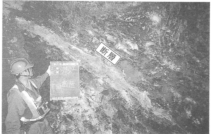
写真-2 切羽で観察された断層
