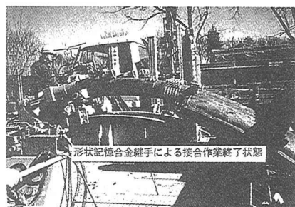
写真-5 曲線ルーフSMA継手試験状況
