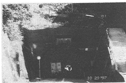
No.6 滑石トンネル
