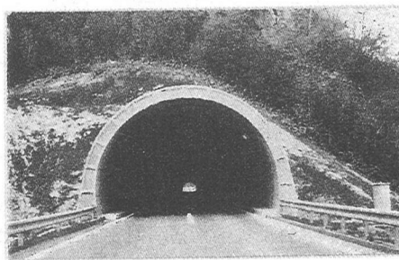
No.17 曲田トンネル
