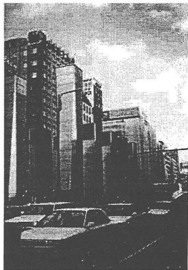
写真-1 長堀地下街・換気塔
