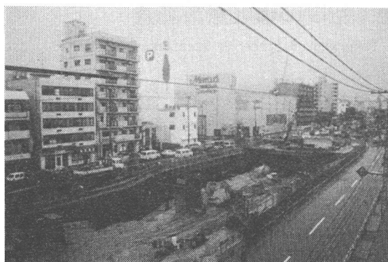
写真－１ 神戸高速鉄道大開駅の復旧工事
