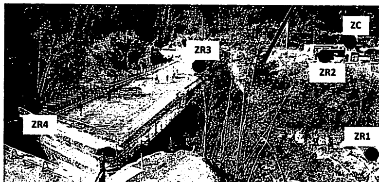
図-8. 橋梁上部工の現場全景とルータ（ZR）設置位置
