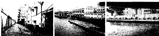
写真-32 高いコンクリート堤防で分断されていた隅田川
