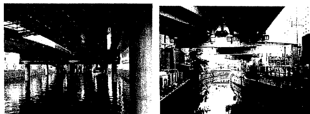
写真-1 高速道路に上空を覆われた都市河川 (左: 日本橋川、右: 渋谷川)
