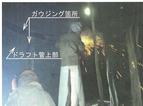
図-12 ガウジング施工状況
