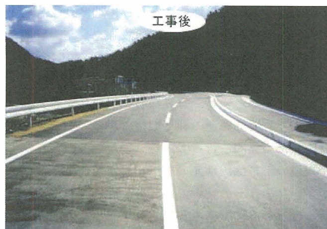
(b) 工事完成後の状況
