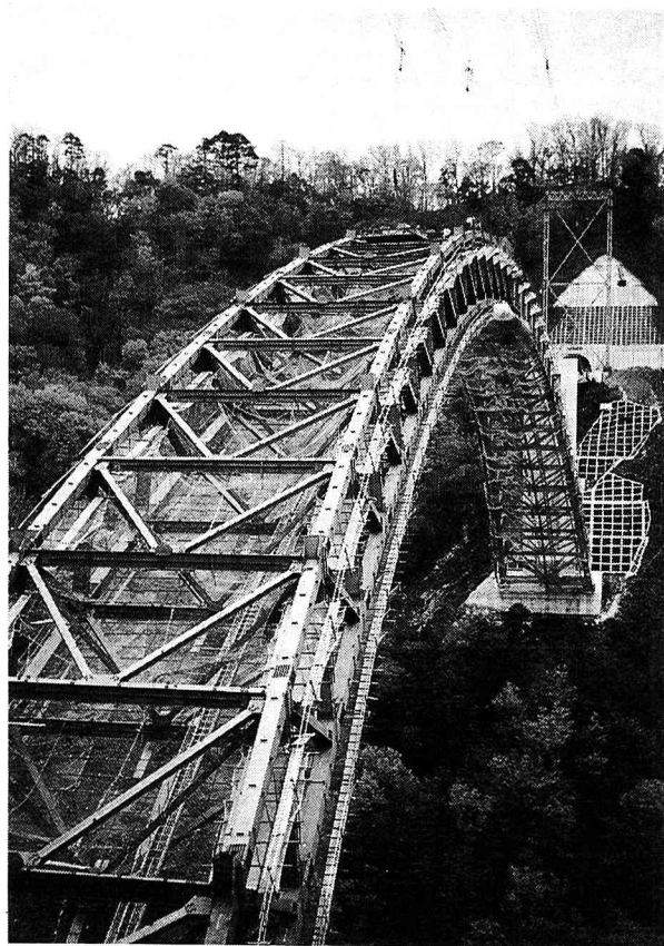
写真-1 アーチリブの架設状況
