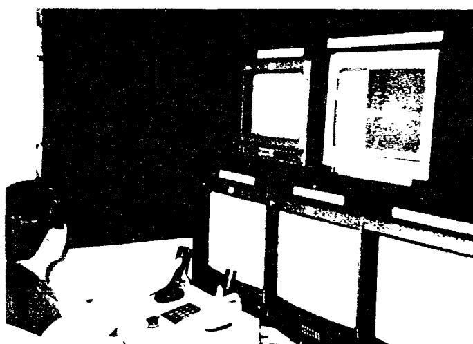
写真-3 コントロールルーム（2期工事）
