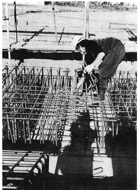
写真-2 ユニット鉄筋相互の結束状況
