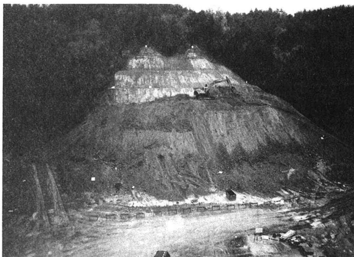
写真-6 計測対象斜面
