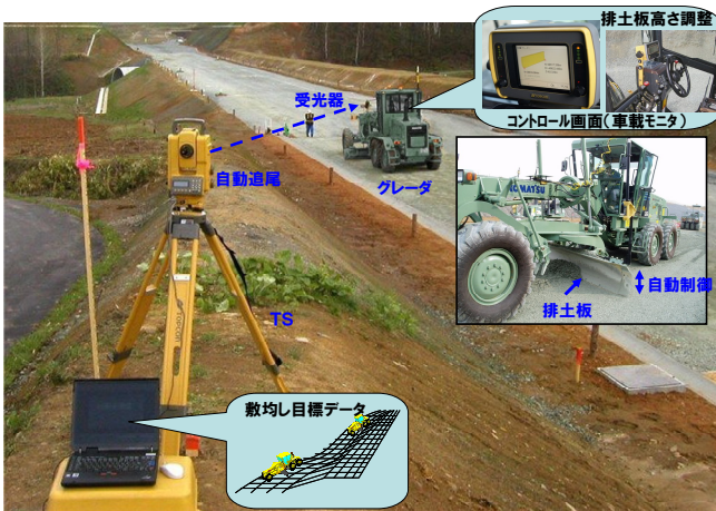
図-2 マシンコントロール技術
