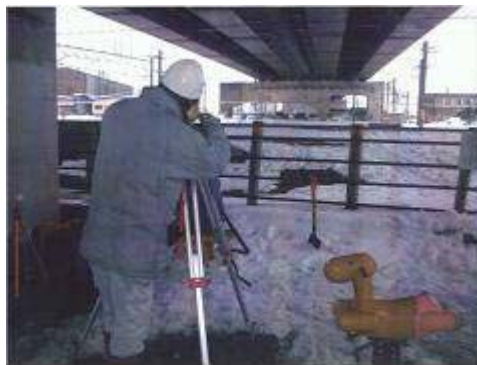
図 - 2 2 ひび割れ測量状況
