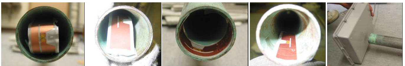
(a) 縦設置 (b) 斜め設置 (c) 円周方向設置 (d) 管軸方向設置 (e) アンテナの向き
