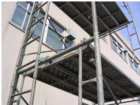
(a) 足場枠の短い側面に貼り付けた IC タグ
