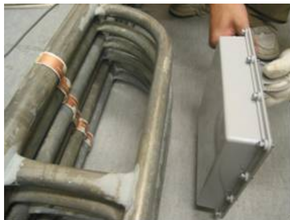
図-8 建て枠（③の円周方向設置、I方向から）
