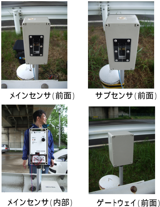
図-15 試作機の設置状況
