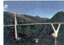
図-2.47 鮎の瀬大橋
