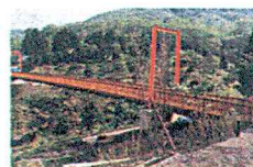
図-2.57 杉並自然村歩道橋
