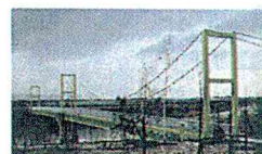
図-2.58 たきかわ吊橋
