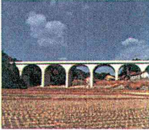
図-2.5 柁坂高架橋
