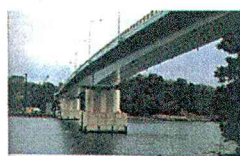
図-2.30 パール1号橋
