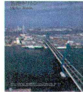
図-2.38 名港東大橋
