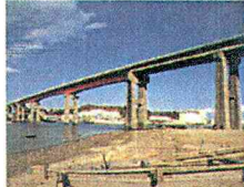
図-2.18 城ヶ島大橋
