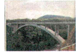
図-2.16 三貫目大橋
