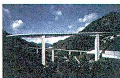
図-2.29 雷電廿六木大橋
