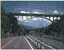
図-2.9 赤谷川橋梁
