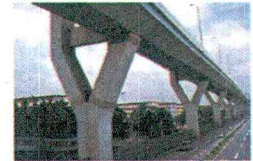
図-2.24 辰巳高架橋
