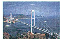
図-2.59 安芸灘大橋
