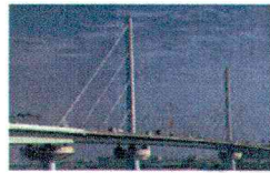
図-2.34 大和川橋梁
