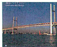
図-2.42 横浜ベイブリッジ
