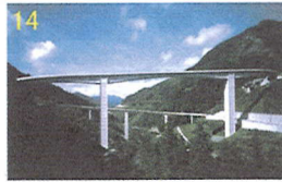
図 4.14 雷電廿六木大橋
