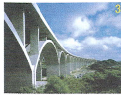
図 4.3 南風原高架橋
