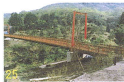
図 4.25 杉並自然村歩道橋
