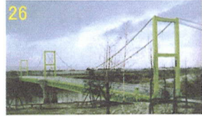
図 4.26 たきかわ吊橋
