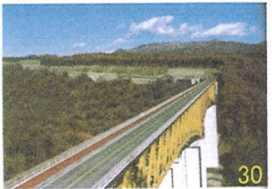
図 4.30 八ヶ岳高原大橋
