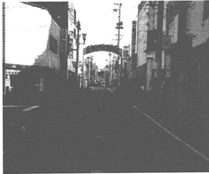
図 4: 電柱 61 番の位置から 59 番を見る写真
