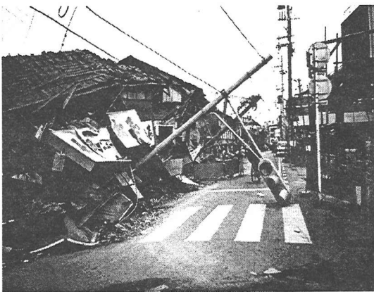
図1.1 倒壊建造物による道路の閉塞
