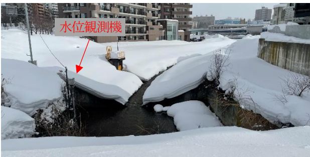
図-7 三里川 1.2k の水位計の設置状況
