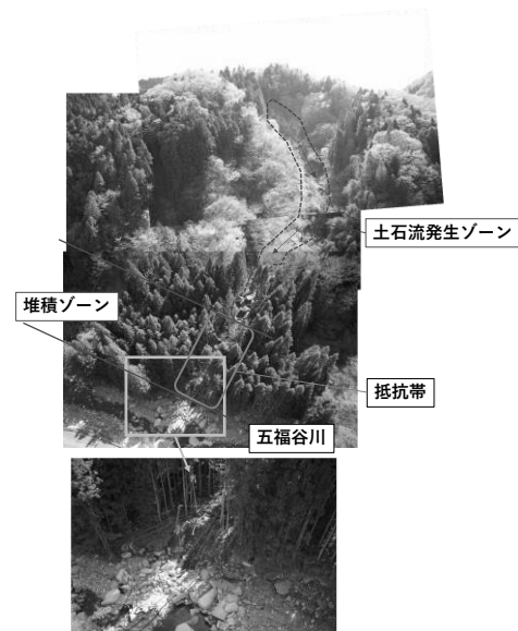
写真-1 五福谷川斜面崩壊土砂緩衝事例(地点 45)
