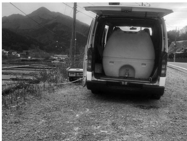
図-5 水タンクを積載したレジアスエースバン，水中ポンプ，2kVA発電機を用いた計測の概況。
