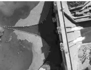
図-22 UAVによる垂直写真
