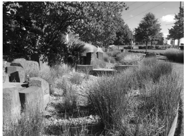
写真-2 都市雨水の浄化施設
