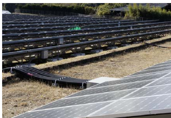
写真4 処分場雑壇ごとに土堰堤を設置
