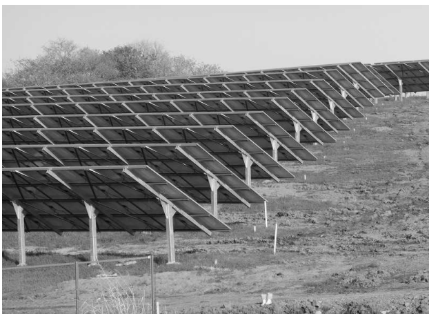
写真-4 S E P イ型架台施工例（浦河町）
