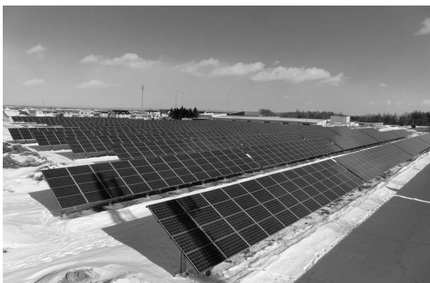
写真-3 S E P イ型架台施工例（帯広市）
