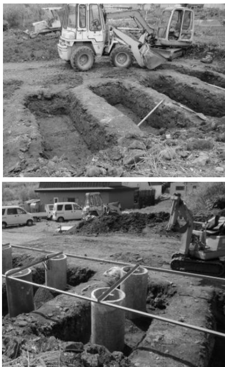
図-2 野立太陽光発電システム用基礎の施工例
