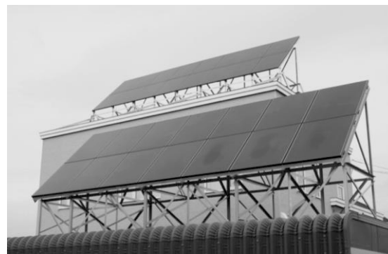
図-1 アトラス工法による屋根パラペット部への架台保持（白い四角内）の工事状況（上）および設置後の概観（上部、手前下部はガレージに設置したもの）風景
