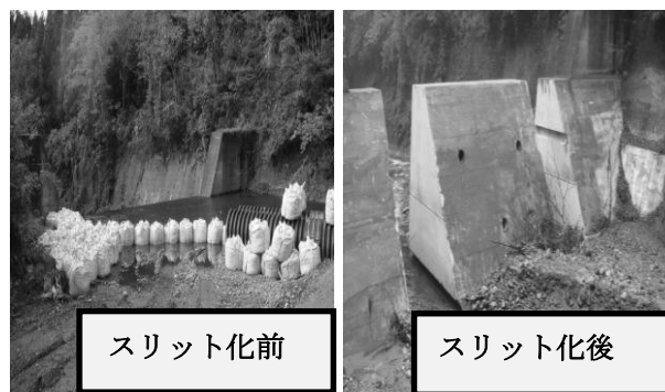
図-1 早田川 第一ダム スリット化の前後
