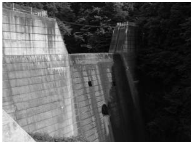
図-8 高井砂防堰堤（切替後の状況）
