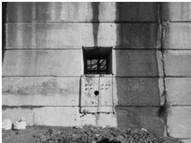
図-6 既設堰堤貫通孔の施工状況
