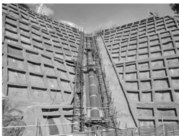
図-4 水圧管路斜面の状況
