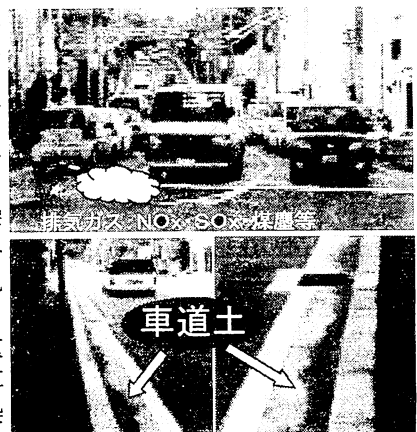
写真1 車道側辺に集積・残存する車道土
