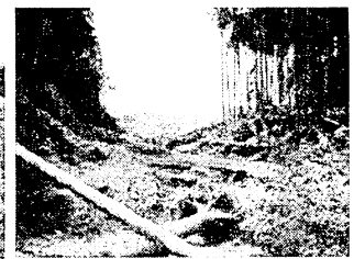
写真-8 ダム決壊全景
