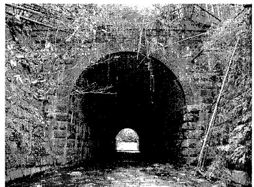
写真-1 瀬久谷川暗渠(肥薩線)
