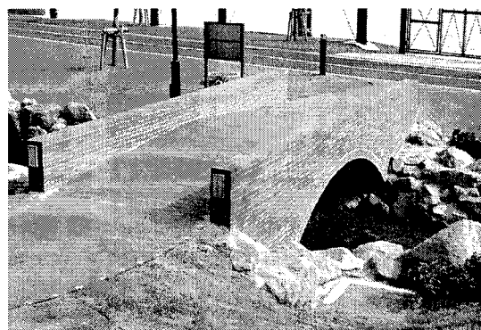
写真-6 同 さいせい橋
