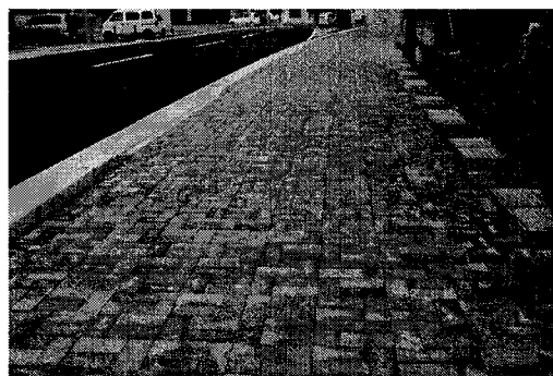
写真-4 湧水ゴンの子煉瓦による舗道
