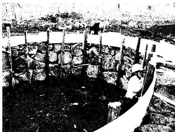
写真-4 窯内部の状況（石積み）
