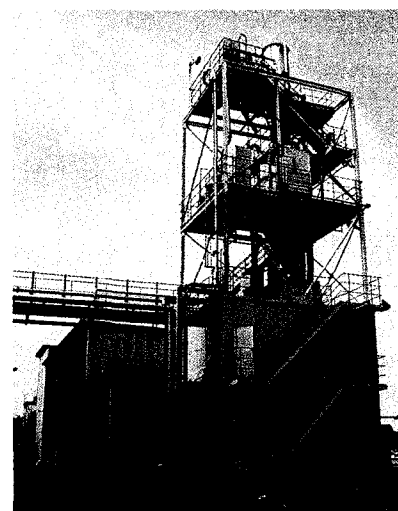
図 2 固化碎石製造設備(3t/h)
