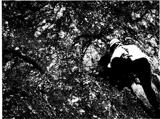
写真-2 岩盤法面に作った窪み (根床)
