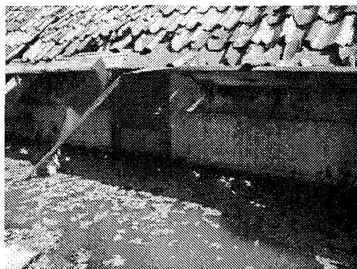
写真3：水没した住宅（スマラン）
