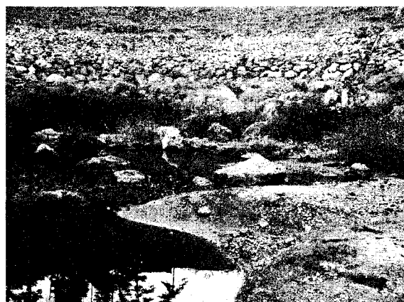
写真3 調整池法尻の石積み・湿地部
