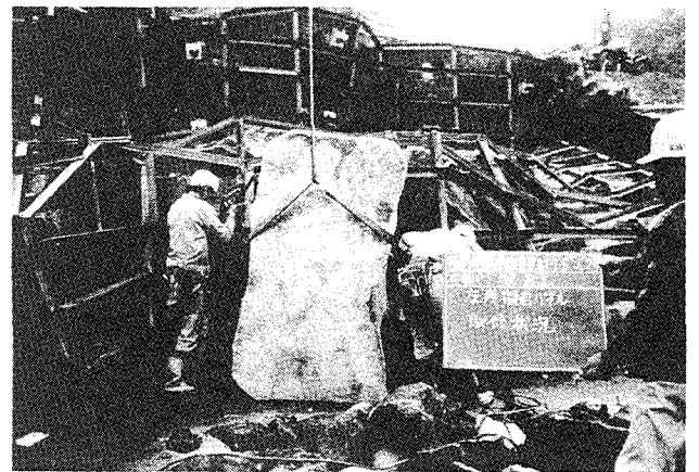
写真-2 擬岩パネル取付状況
