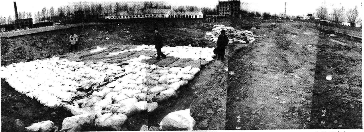
図16：ハルビンにおける氷塊保存・利用実用化実験地。地中に、10m×10m×厚さ3mの氷塊が造られている。6月に氷庫に連続して生野菜等の貯蔵庫（10m×6m×3m）が造られる。右手の道路は、幹線国道102号《ハルビン⇄北京》
