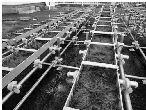
写真-1 人工水路と浄化用植物の設置状況
