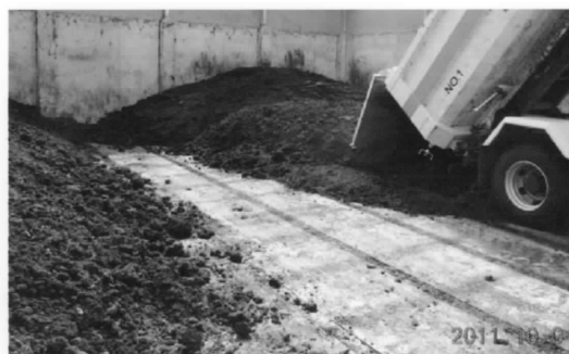
写真1 資源リサイクルセンターの写真 （脱水汚泥搬入時）
