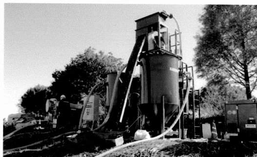
写真-2 つつじが岡公園に設置した浚渫装置
