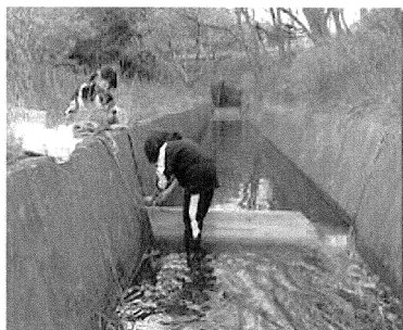
写真-1 堰の設置作業
