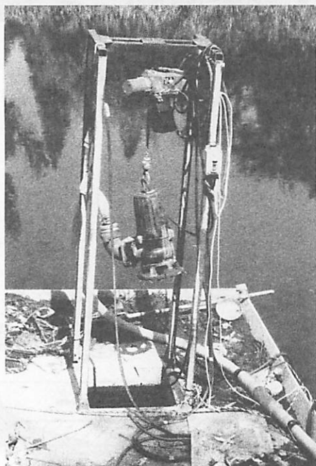
写真2 作業台船と底泥攪拌ポンプ
