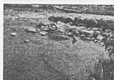
写真-4 水制工の設置により形成された砂州
